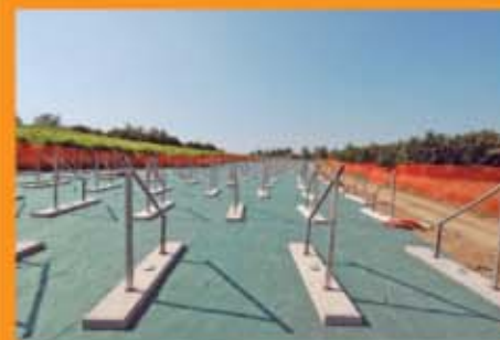
I teli Barbiflex per evitare erbe infestanti nel campo fotovoltaico
